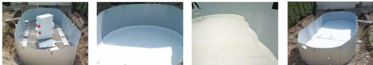
Die Bodenisulationsplatten inkl. der Styroporkeile werden erst nach Errichtung des Grundgerüstes (Einführung des Stahlmantels in Bodenschienen) in die daraus entstehende ovale Form geschnitten. Der Vorteil ist, dass sich die Zugbänder unter dem Bodenisolationset befinden. Dadurch werden Schäden und Formabbildungen verhindert. Als Trennlage zur Folie wird ein Vlies aufgebracht.
