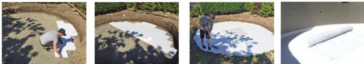
Die Bodenisulationsplatten inkl. der Styroporkeile werden bereits vor Errichtung des Grundgerüstes (Einführung des Stahlmantels in Bodenschienen) auf die vorbereitete Fläche angepasst. Sobald die Bodenisulationsplatten verlegt sind kann mit dem Aufbau des Grundgerüstes begonnen werden. Nach Errichtung des Grundgerüstes werden die Styroporkeile mit dem mitgelieferten Styroporkleber verlegt. Als Trennlage zur Folie wird ein Vlies aufgebracht.
